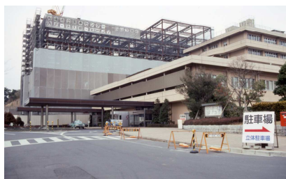
A館建設時の様子
